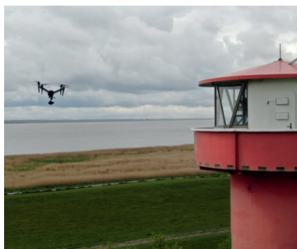
Abb. 5: UAS-Einsatz in der WSV. Quelle: WSA Elbe-Nordsee
