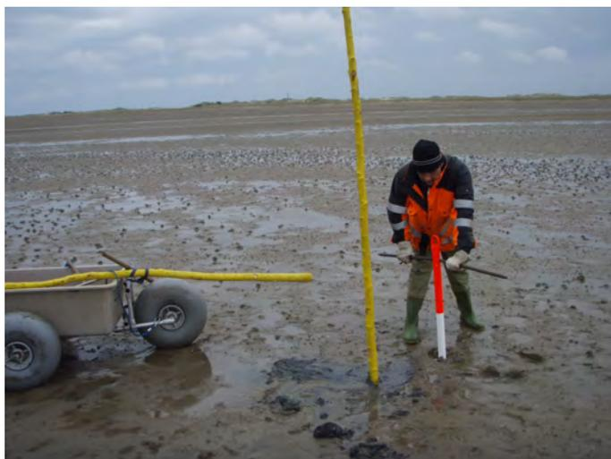
Abbildung 13.1.: Setzen eines Schraubpfahles. (Bild: Wasserstraßen- und Schifffahrtsamt Emden)
